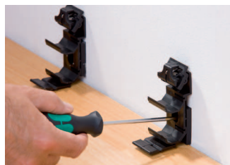
Befestigungsschelle anbringen
