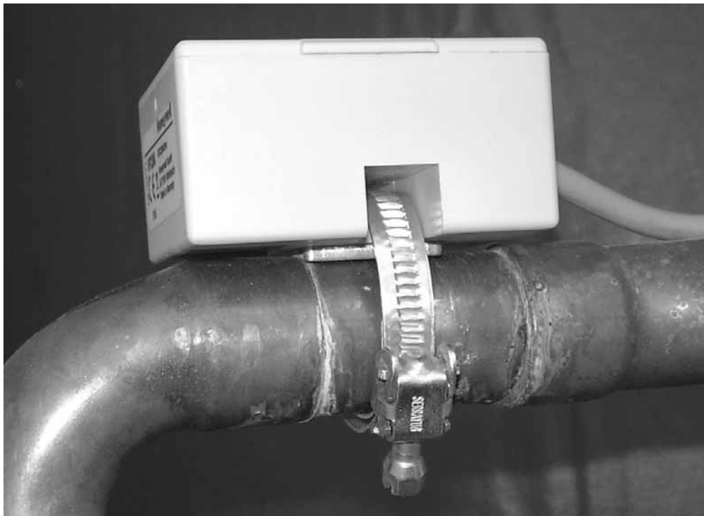
Der Anlegerfühler hinter dem Mischer in den Heizkreis
