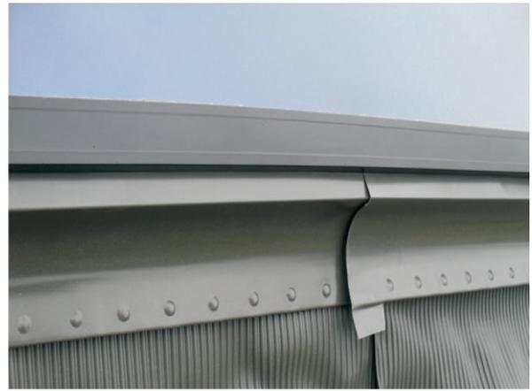
Recourber les lamelles qui intègrent les éléments de montage.
