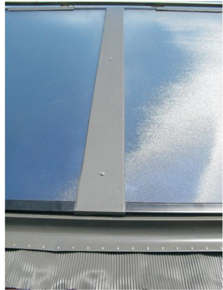
Fixer la gaine centrale à l'aide de vis avec rondelles d'étanchéité.
