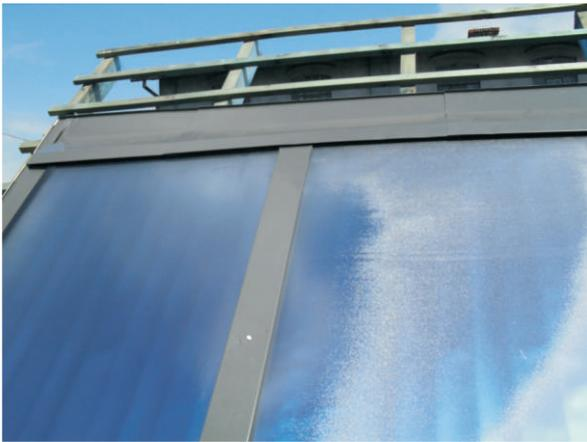
Poser l'élément supérieur gauche de la bride en le glissant dans l'élément supérieur central déjà installé. Placer en bas le support de la bride supérieure. Fixer simultanément aux chevrons de l'arbalétrier à l'aide de vis avec rondelles d'étanchéité.
