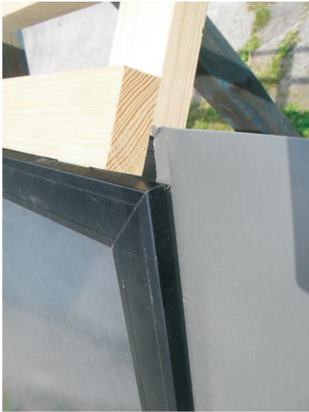
Recourber la partie incisée de la bride de la gouttière latérale droite et placer la bride sous la barrette du capteur. Répéter l'opération de l'autre côté de l'ensemble.
