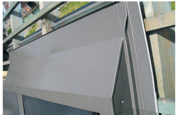
Mettre l'élément supérieur central de la bride en le glissant dans l'élément supérieur droit déjà installé. Placer en bas le support de la bride supérieure. Fixer simultanément aux chevrons de l'arbalétrier à l'aide de vis avec rondelles d'étanchéité.
