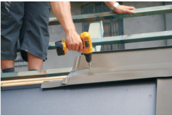
Poser l'élément supérieur droit de la bride en plaçant en bas le support de la bride supérieure. Fixer simultanément aux chevrons de l'arbalétrier à l'aide de vis avec rondelles d'étanchéité.
