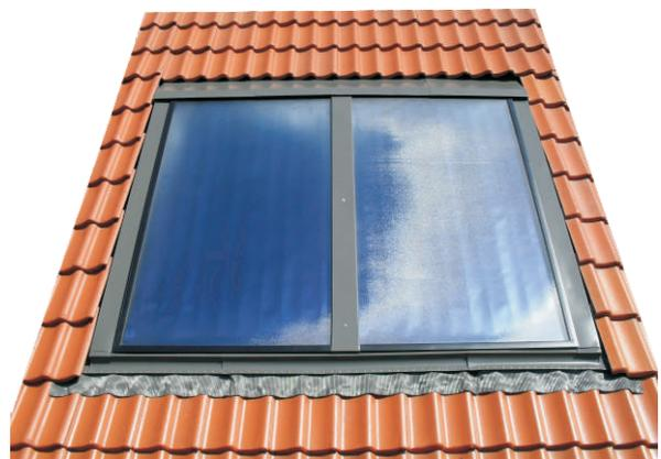
Remettre les tuiles manquants et coller la tablier des éléments inférieurs de la bride.
