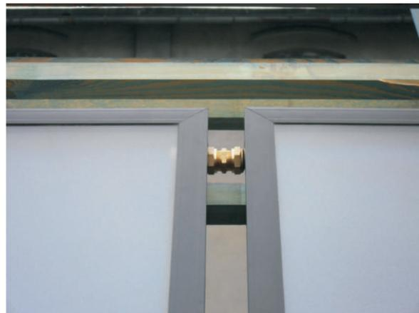
Placer le deuxième capteur et en même temps poser un raccord-union entre les deux capteurs. Veiller à ce que l'écart entre les barrettes du capteur soit de 55mm.
