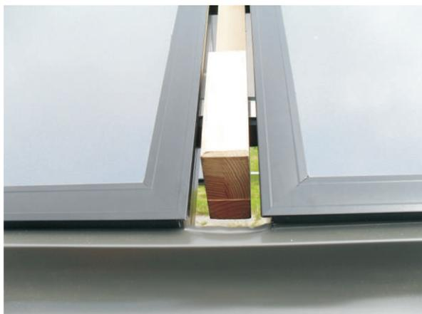
Glisser de nouveau l'élément inférieur central de la bride et recourber le fragment incisé de façon qu'il soit possible de glisser la gouttière centrale.
