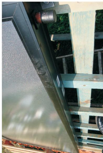
Du côté extérieur, fixer les capteurs aux chevrons du toit à l'aide de lamelles et de vis.
