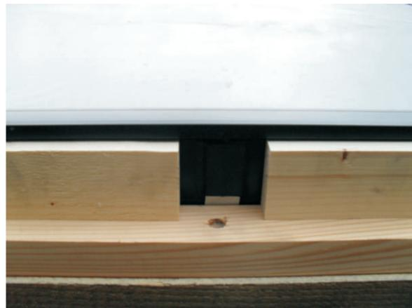
Le cube doit se trouver au milieu de l'entaille. Laisser un espace de 2mm entre le support de la bride inférieure et la baguette. Si l'écart est plus petit, il faut abaisser la baguette.
