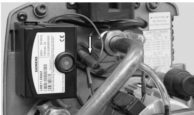
Abb. 22: Ionisationskabel mit Stecker
