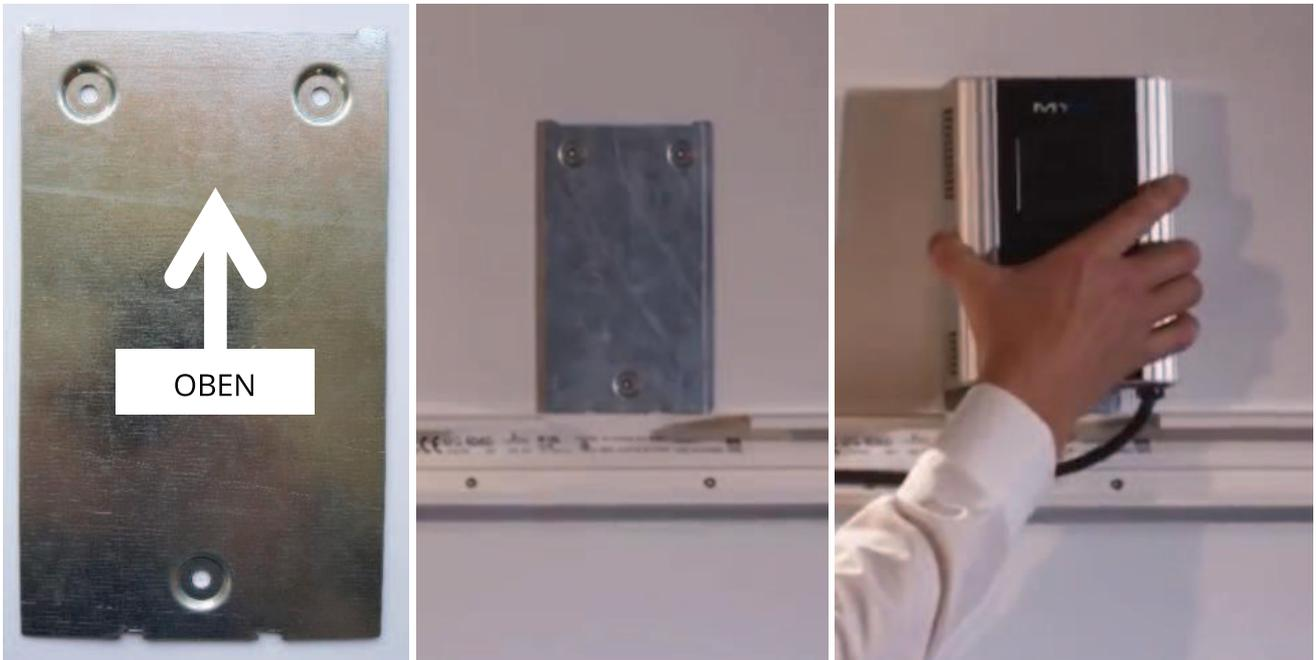
Zur Befestigung an der Wandhalterung ist der AC•THOR mit den beiden Langlöchern an der Oberseite in die Wandhalterung einzuhängen und anschließend mittels Verriegelung an der Unterseite zu fixieren (nach links schieben).
