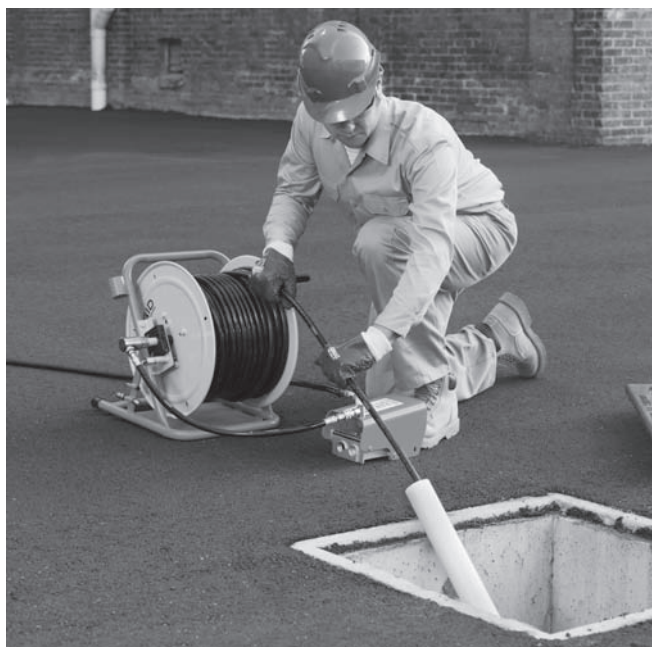
Slika 10 – Produžavanje otvora odvoda do radne točke
