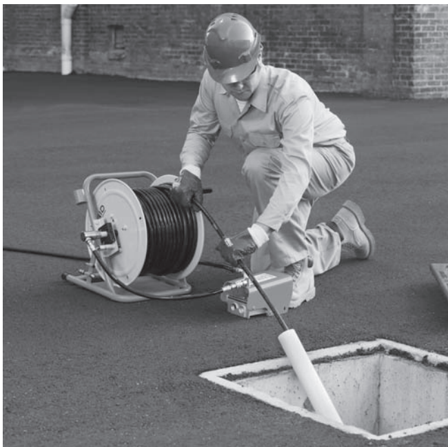
Slika 10 – Produžetak otvora odvoda do mesta rada
