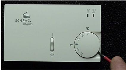
1. Temperaturwahlschalter mittels Schraubenzieher abziehen.
