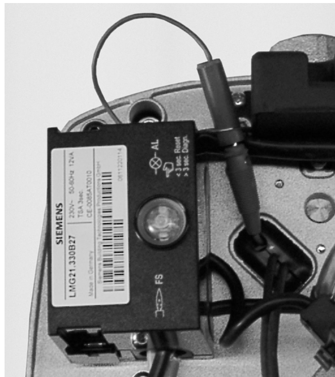
Abb. 20: Der Anschluss der Ionisationselektrode ist steckbar ausgeführt.
