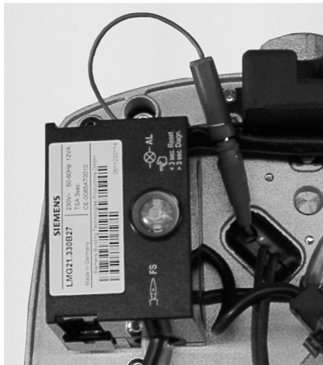
Abb. 20: Der Anschluss der Ionisationselektrode ist steckbar ausgeführt.
