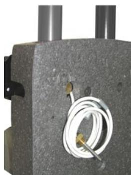
5. - Mettez le câble de la sonde de départ dans le trou spécial au milieu de la coque isolante, pour le faire sortir du trou derrière en correspondance de la vanne à boisseau sphérique à trois voies (voie de départ).
