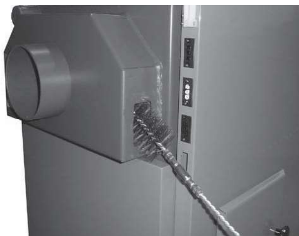
Vorführung der Reinigung des Rauchkanals. Wird nach Reinigung des Rohrbündels in Verbrennungskammer des Kessels durchgeführt
