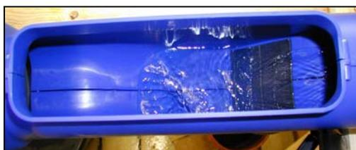
Reinigung des Filters nach Wechselsprung
