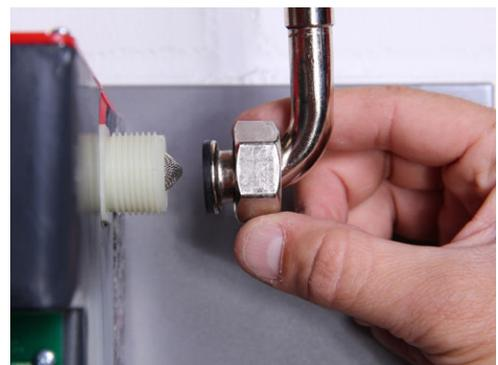
Die andere Seite des Flexschlauchs (Überwurfverschraubung) mit dem in der Trinkwasserleitung montierten Absperrhahn verschrauben.
