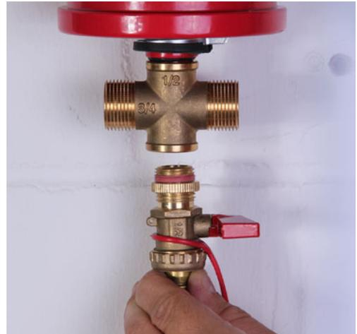
Danach wird der Druckabsperrhahn mit der Überwurfverschraubung (Dichtung) mit dem T-Stück verbunden.
