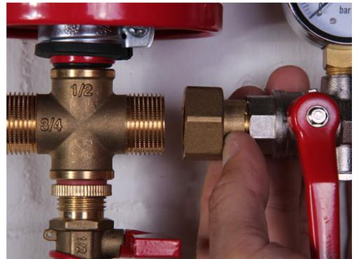
Der Flexschlauch verbindet Pumpendruckanschluss und T-Stück des Ausdehnungsgefäßes.
