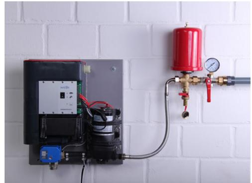
Der Vordruck des Ausdehnungsgefäßes muss überprüft werden (s. Kap. 5.4).
