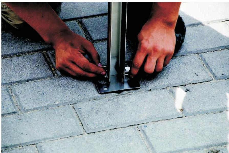
Raccordez les composants du kit (1)(4)(5) en utilisant un set de vis (17).
