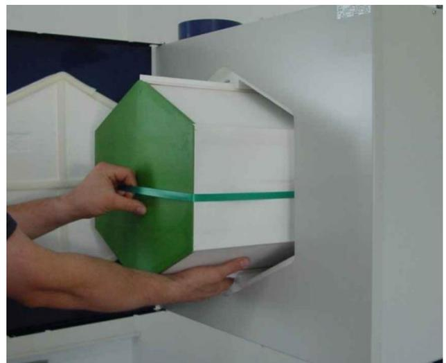
Nun den Wärmetauscher wieder vorsichtig in das Gerät einschieben. Hierbei besonders auf die obere und untere Führungsnut achten. Im Anschluss an die Reinigungsarbeit setzen Sie die schwarze Dichtmatte mit der glatten Fläche Richtung grünen Wärmetauscher wieder ein und schließen die Revisionstüre.
