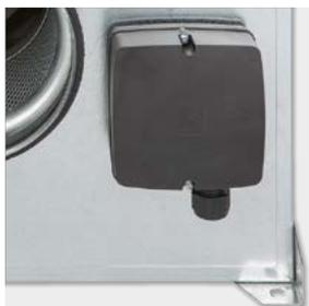
**Externer, wasserdichter Klemmenkasten (IP55)**
