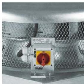
**Wasserdichter Klemmenkasten (IP55) mit Wartungsschalter**
