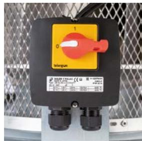
**Wasserdichter Klemmenkasten (IP55) mit Wartungsschalter**
