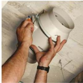
Setzen Sie die Motoreinheit ein.
