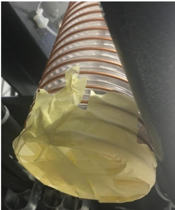
2. Abgaskompensator demontieren
