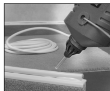
Förläggning av telefonkabel.
