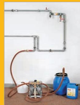
3. Après l'avoir chargé conformément aux instructions, le conduit sera soumis à une pression de 4 bar plus 1 bar pour chaque 10 mètres en hauteur de l'installation à étancher. Ainsi on presse la substance d'étanchement dans les raccords filetés qui ne sont pas étanchés.
