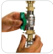
1. Lösen der Verschraubungen
