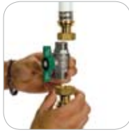
3. Einsetzen des neuen Kugelhahns
