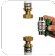
2. Entfernen des alten Kugelhahns
