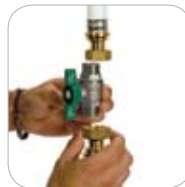
3. Einsetzen des neuen Kugelhahns
