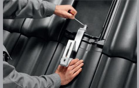
Verstellbarer Dachhaken für die Aufdachmontage.
