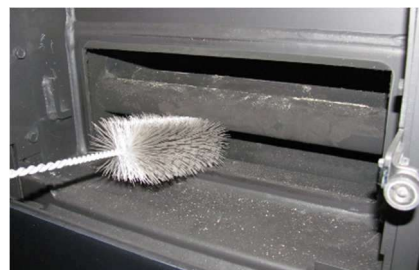
Abb. 37: Reinigung Wärmetauscher
