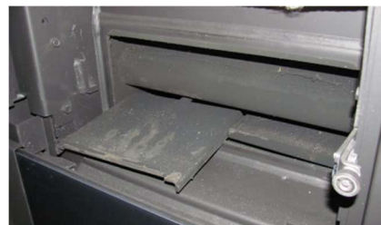
Abb. 36: Entfernen Stahlblech Umlenkungen
