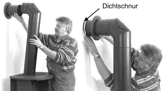
Abb. 7: Installation Verbindungsstück
