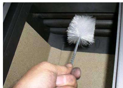
Abb. 39: Reinigung Wärmetauscher
