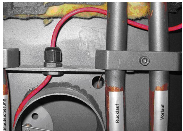
Abb. 25: Zugentlastung Kesselfühler
