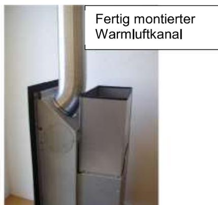
Unbedingt Schrauben von innen anziehen, damit die Stutzen später ohne Ausbau des Gerätes gelöst werden können.
