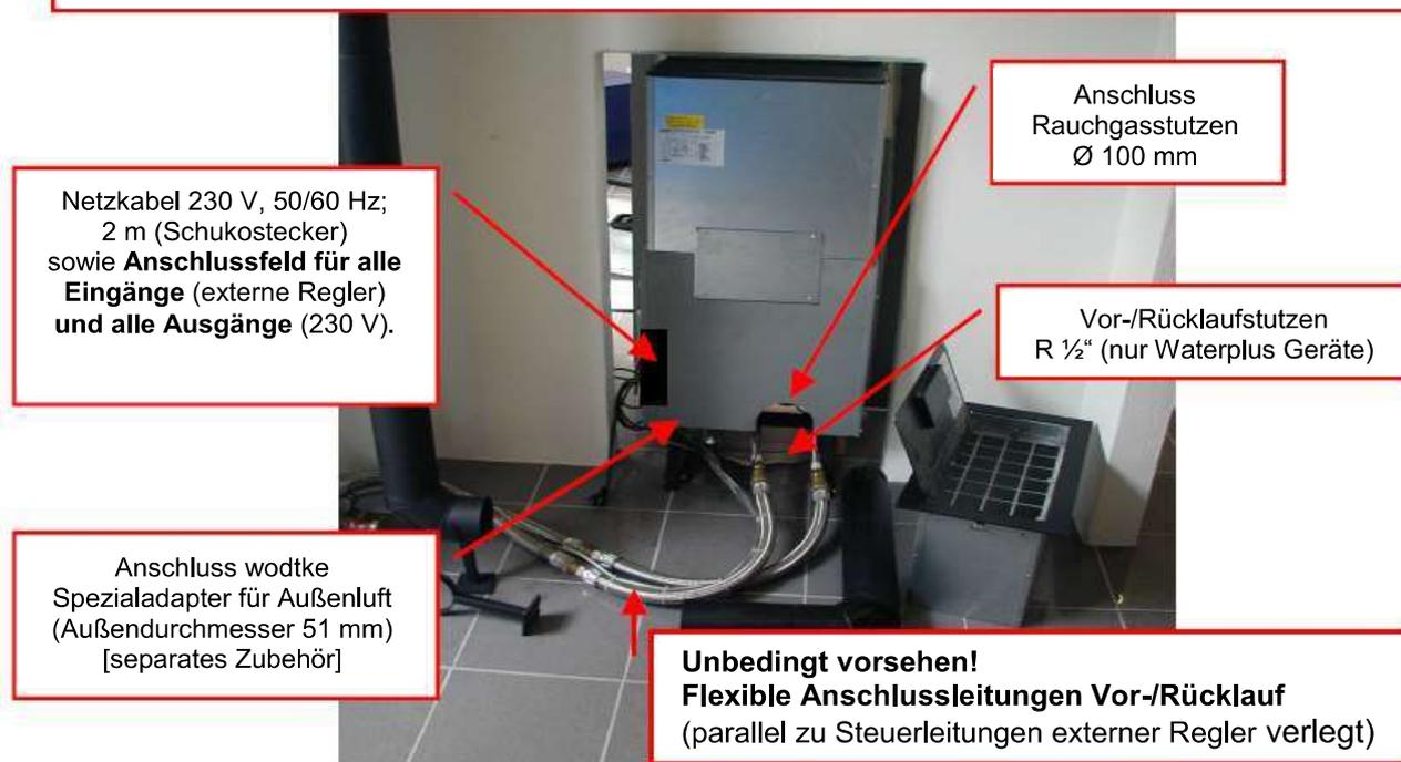
Bildbeispiel zum rükwärtigen Anschluss aller Versorgungsleitungen / Anschlussleitungen.
