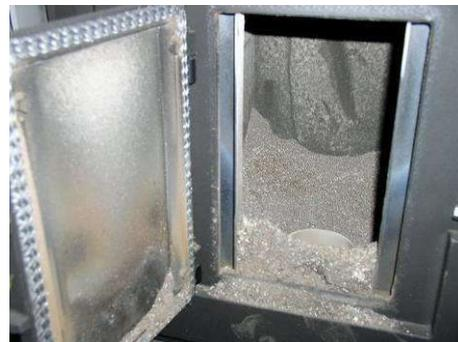
Abb. 95: Verschmutzter Feuerraum
