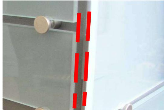
Abb. 34: Detail Ausrichtung Dekorgläser
