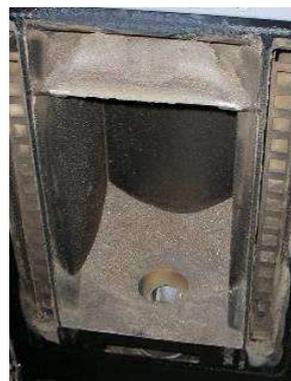
Abb. 111: Normale Verschmutzung (trockene Flugasche).
