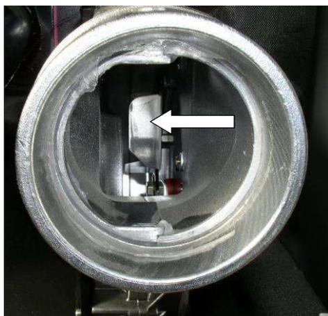
Abb. 144: Abluftstutzen mit Flügelrad
