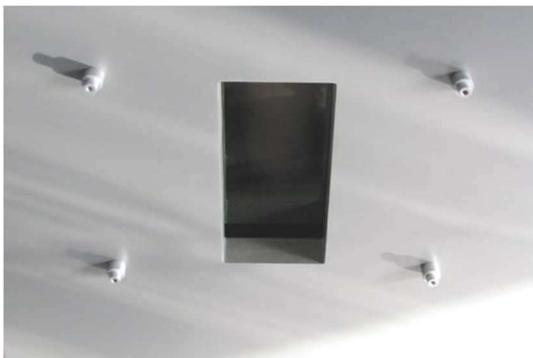
Abb. 38: Glashaltebolzen eingeschraubt
