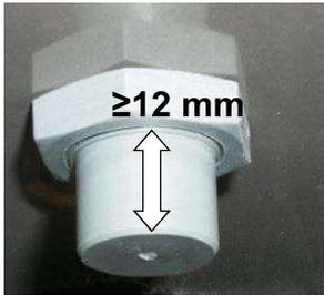
Abb. 64: Einbautiefe Füllstandmelder
