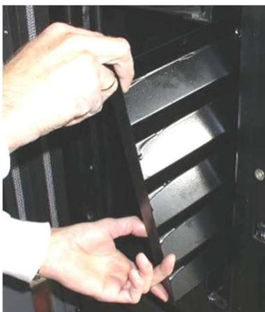
Abb. 135: Entnahme Turbulator
