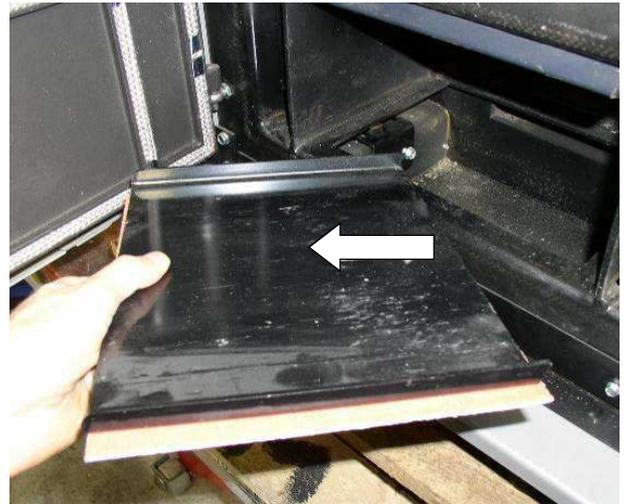
Abb. 140: Entfernen Abdeckplatte Heizgassammler
