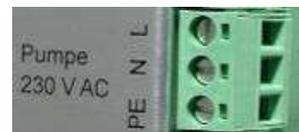
Abb. 75: Ausgang Pumpe
