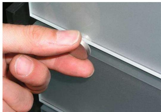
Abb. 36: Detail Verschraubung Dekorglas
