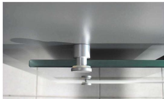
Abb. 41: Dekorglas montiert
