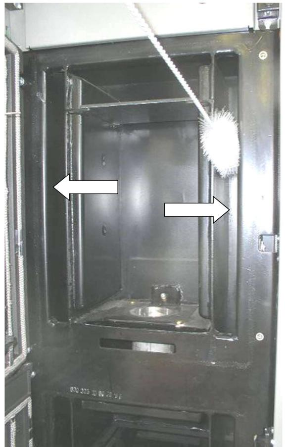
Abb. 137: Reinigung Heizgaszüge oben
