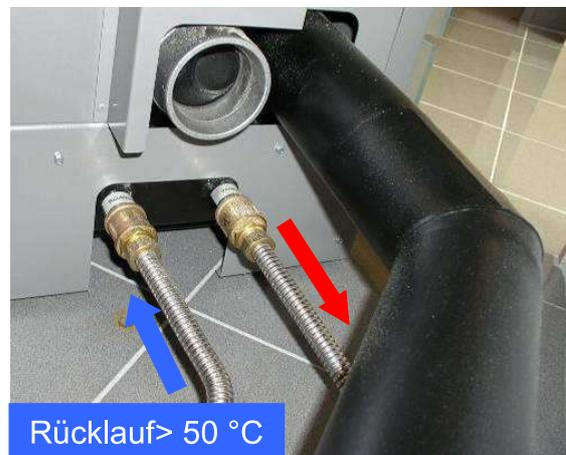
Abb. 43: Hydraulische Anschlüsse BM 01
