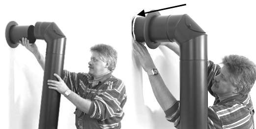
Abb. 1: Anschluss Rauchrohr am Schornstein
