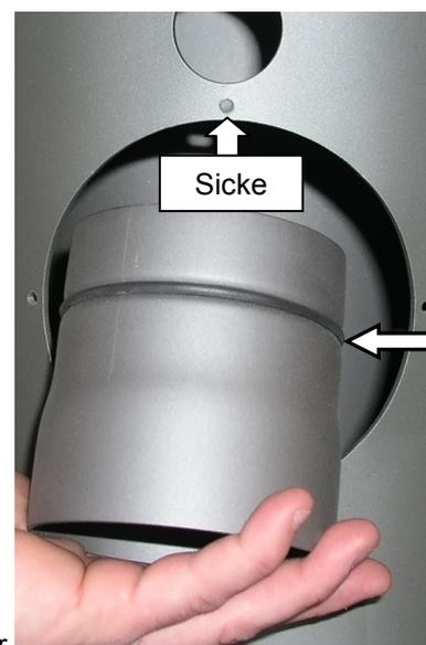
❗ Sofern die **Sicke** nach oben montiert werden muss, vor der Montage den Dichtring entfernen!
