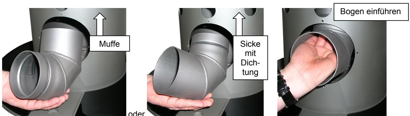
Der Dichtring zwischen Anschluss-Rohr und Anschluss-Bogen stellt die bewegliche Verbindung dar. Rohr und Bogen daher nicht zu weit ineinander stecken, damit diese nicht klemmen.
