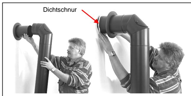
Abb. 16: Montage Rauchrohr
