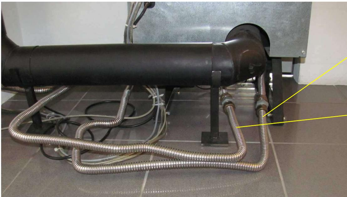
Anschluss Vor- und Rücklauf mit flexiblen Schläuchen (gasdichtes Edelstahlrohr - siehe Zubehörprogramm)
