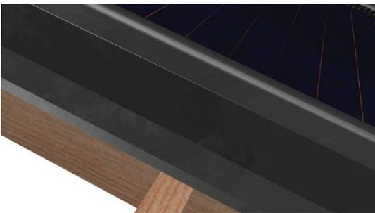
Das obere Seitenblech muss so eingeschoben werden, dass das untere Seitenblech immer min. 10 cm überlappt wird.
