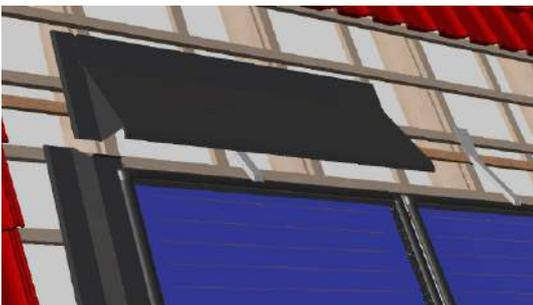
Führen Sie zunächst das Firstblech an der linken Seite in das linke Seitenblech ein. Anschließend wird das Firstblech über die Gummilippe geschoben.
