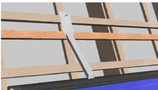
Fixieren Sie vor der Montage der Firstbleche das Versteifungsblech mit entsprechenden Schrauben.
