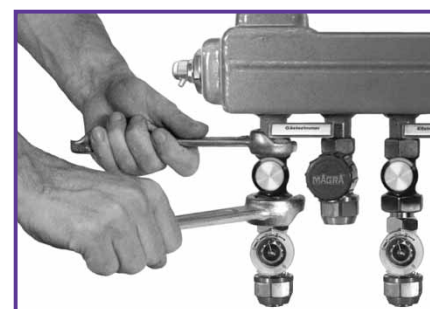
MAGRA-AV SETTER Rondo ansetzen und befestigen.
