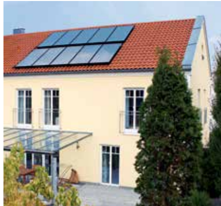
Vitosol 200-FM Zweifamilienhaus Geisenfeld
