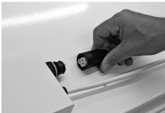
1. Blindstecker vom Steuergerät der Infrarothheizung abschrauben.
